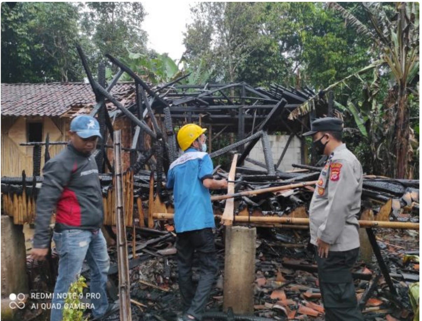
Diduga Akibat Konsleting Listrik Sebuah Pesantren Hangus Terbakar
