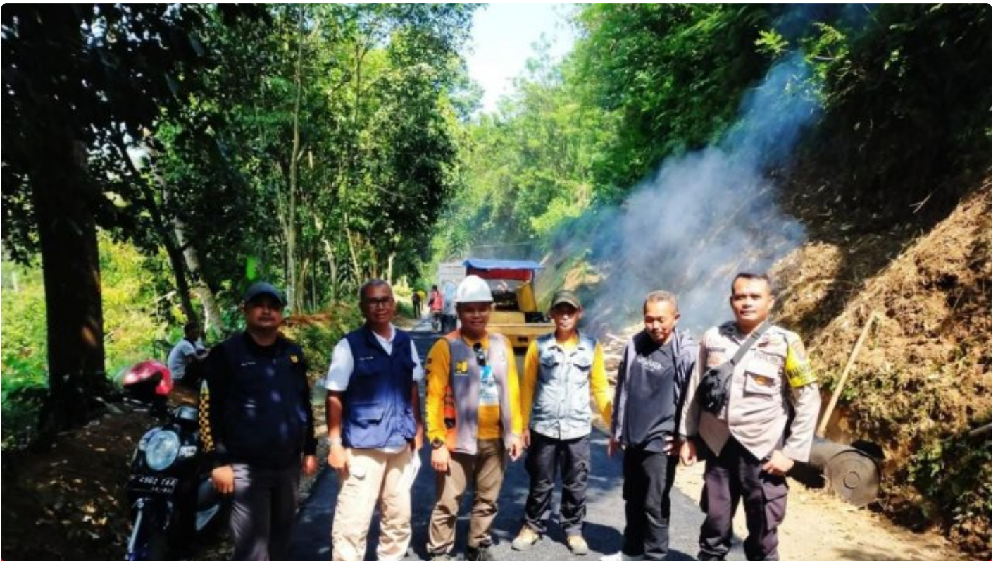
Bhabinkamtibmas Desa Munjul Polsek Nagrak Monitor Pembangunan Jalan Desa
