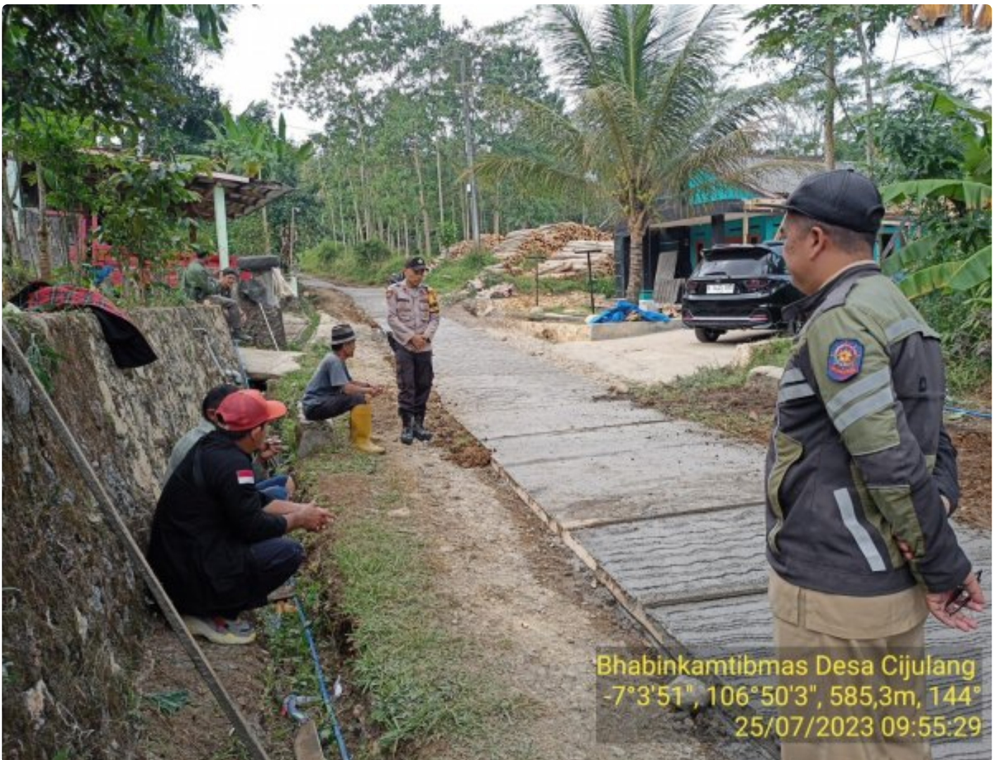
Aipda Sudiro Monitoring Pembangunan MCK di Desa
